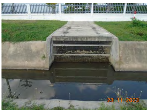
ภาพที่ 2-28 รางระบายน้ำฝนที่เชื่อมต่อกับ ระบบระบายน้ำฝนของนิคมฯ
