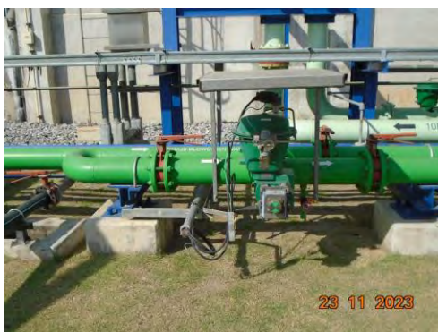
ภาพที่ 2-12 วาล์วควบคุมการปล่อยน้ำทิ้งจากหอหล่อเย็น
