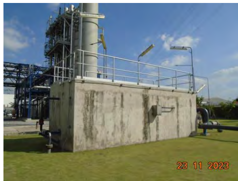
ภาพที่ 2-15 บ่อแยกน้ำ/น้ำมัน (Oil Separator)
