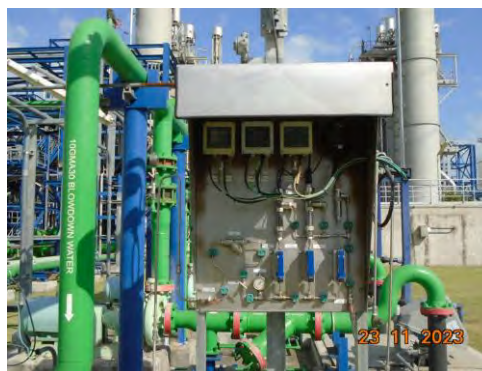
ภาพที่ 2-11 ระบบ Online Monitoring บริเวณบ่อพักน้ำหล่อเย็น
