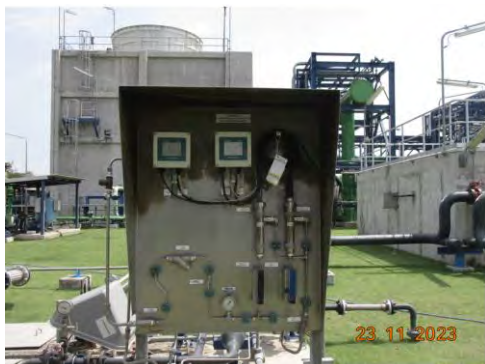
ภาพที่ 2-20 ระบบ Online Monitoring บริเวณบ่อบำบัดน้ำทิ้งรวม
