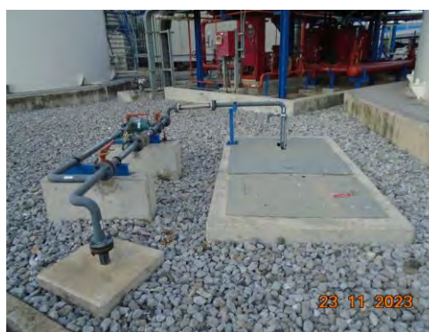
ภาพที่ 2-17 ท่อระบายน้ำทิ้งจากบ่อพักน้ำทิ้งรวม ไปยังระบบบำบัดน้ำเสียส่วนกลางของนิคมฯ
