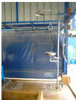
ภาพที่ 2-42 ฝักบัวอาบน้ำฉุกเฉิน และที่ล้างตาฉุกเฉิน
