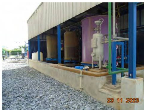
ภาพที่ 2-43 คั่นกันสารเคมีหกรั่วไหล
