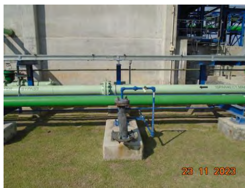
ภาพที่ 2-13 ระบบการเติมอากาศแบบหมุนเวียนน้ำ ในบ่อพักน้ำหล่อเย็น
